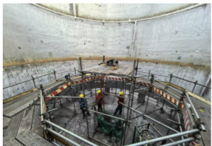
中国石化燕山石化公司 SEI焦炭塔 现场堆焊
