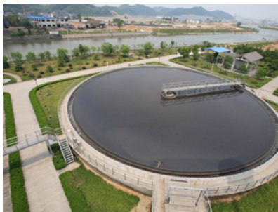
初沉池 / 二沉池池壁、池底及溢流堰
